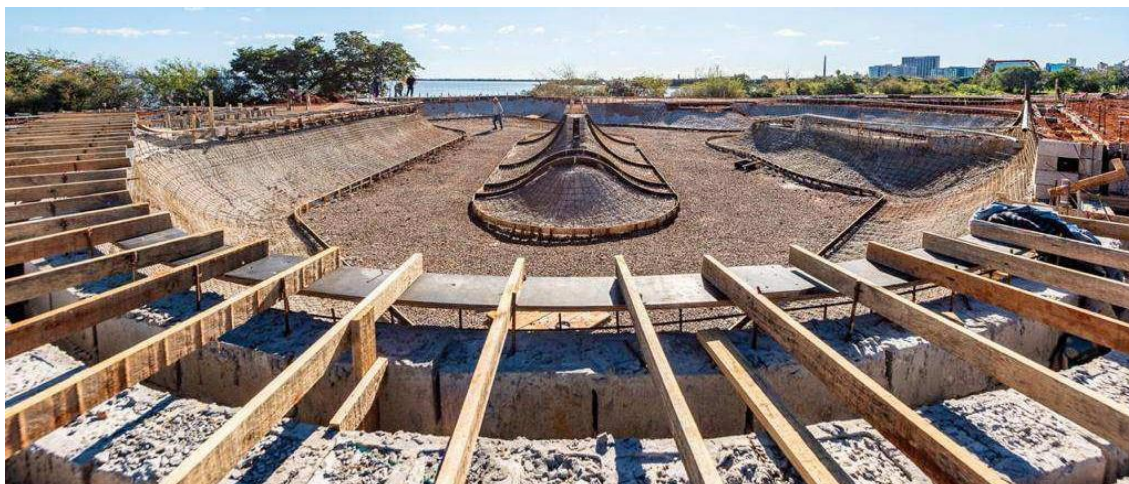
Figura 9 - Foto ilustrativa das formas de madeira
