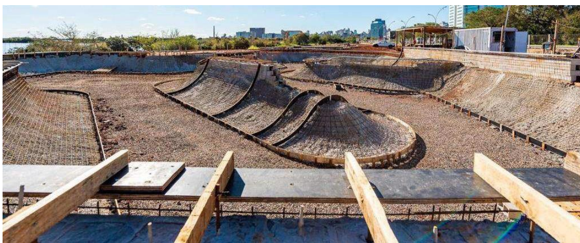
Figura 10 - Foto ilustrativa das formas de madeira
