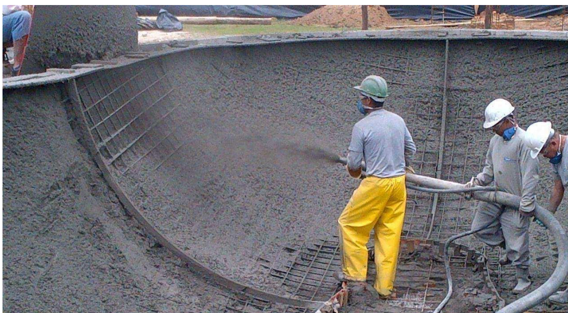
Figura 17 - Foto ilustrativa da projeção de concreto
