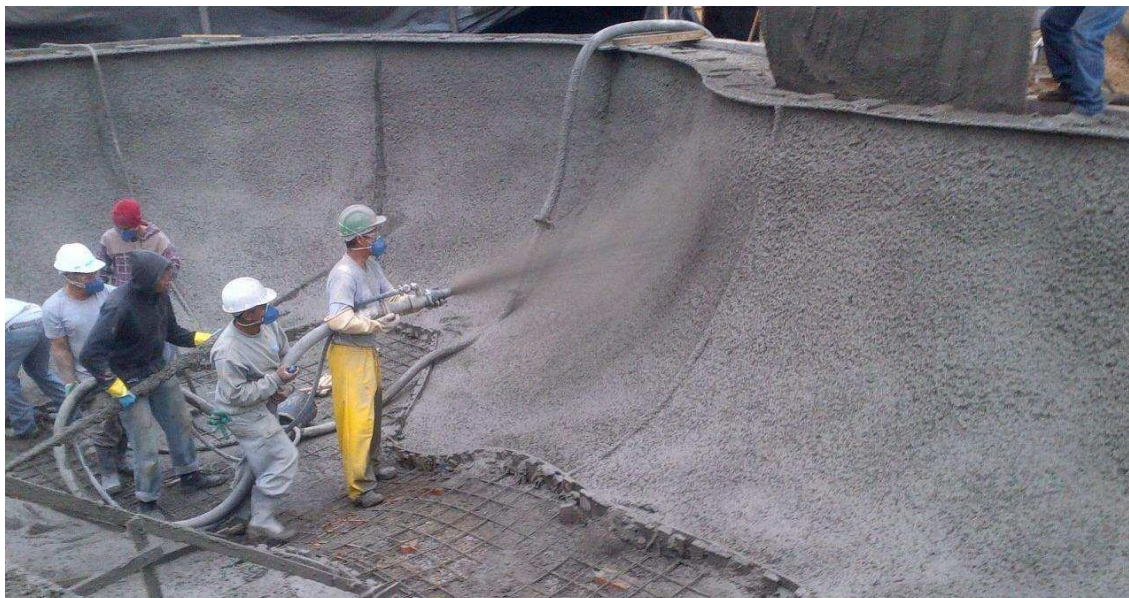
Figura 8 - Foto ilustrativa da projeção de concreto magro
