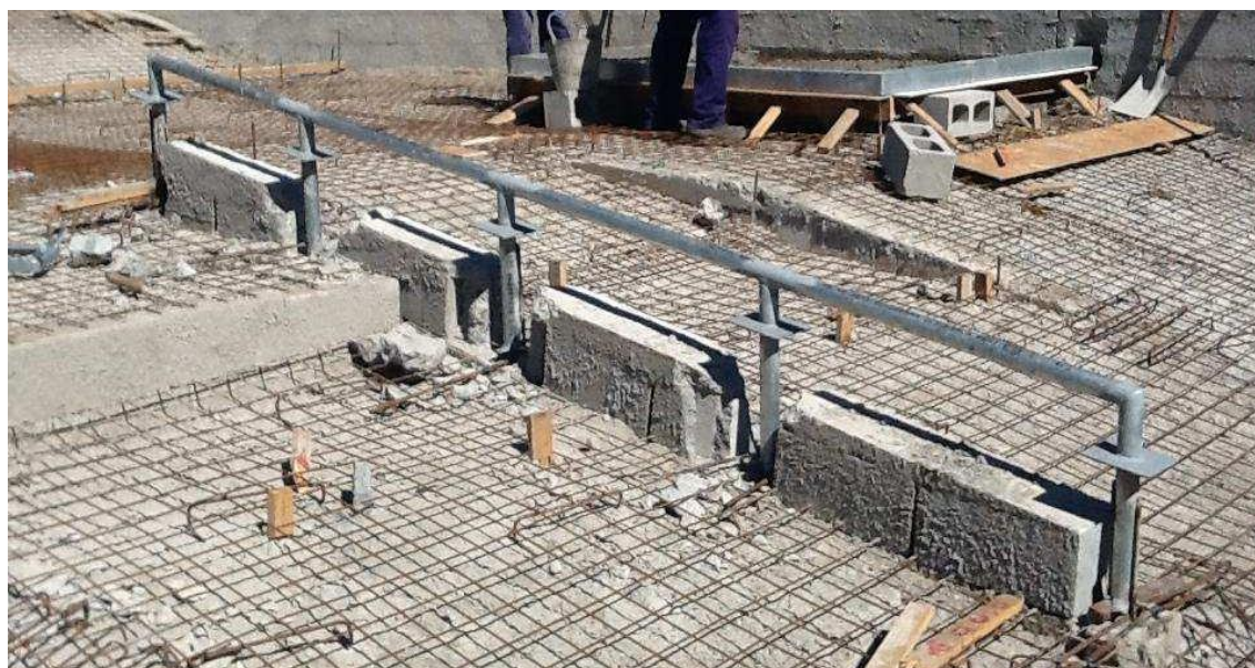
Figura 6 - Foto ilustrativa do corrimão sendo chumbado
