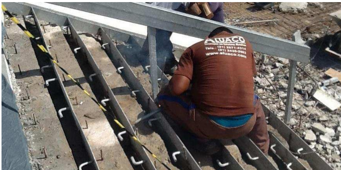
Figura 7 - Foto ilustrativa do corrimão sendo chumbado
